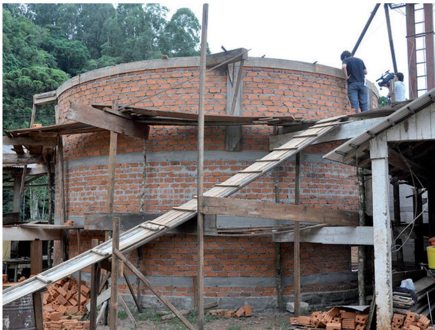
**Figura 4.** Silo secador de alvenaria armada em fase de construção com capacidade estática de 3.000 sacos de milho (moinho Soccol, Casca-RS).
