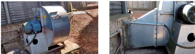
**Figura 9.** Um excelente ventilador a), com uma transição completamente equivocada b)
